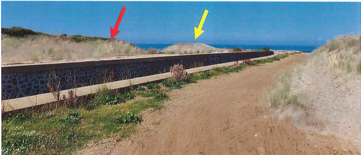
Fig. 17: Tratto di duna esistente (freccia rossa) e tratto di duna nuova (freccia gialla)
