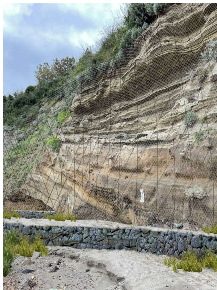
VISTA N. 3: VISTA INTERVENTO DAL PIEDE DEL COSTONE
