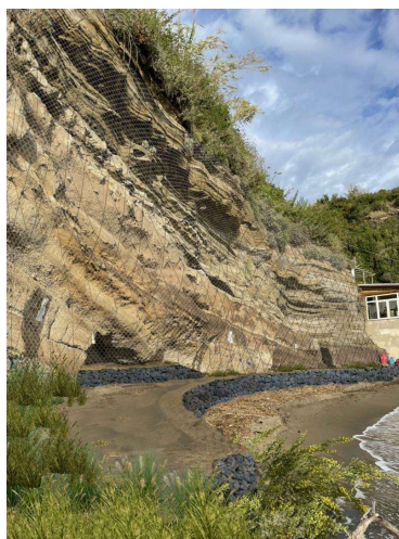
VISTA N. 5: VISTA INTERVENTO DAL PIEDE DEL COSTONE
