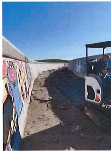
Particolare della sabbia da rimuovere nel fondo del Canale Foce Nord
