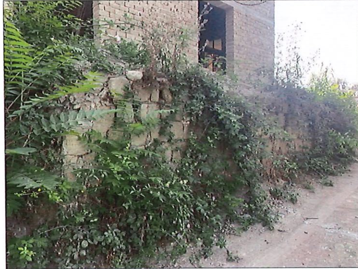
Foto 2 – Lavori in corso
