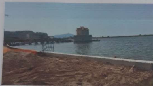
Foto – durante l'intervento -
