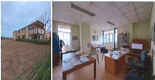
Foto 3 + Interni | Rilievo fotografico
