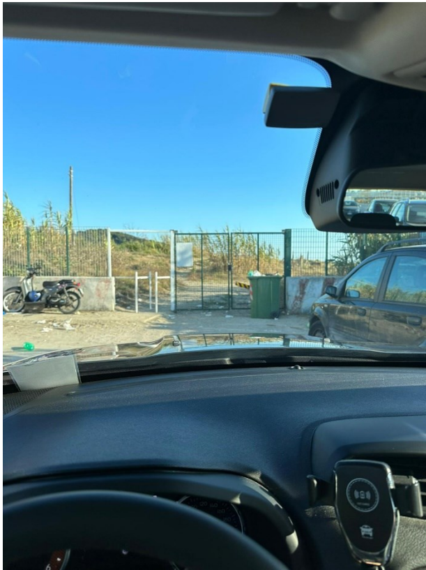
Cancello di accesso ripristinato e chiuso
